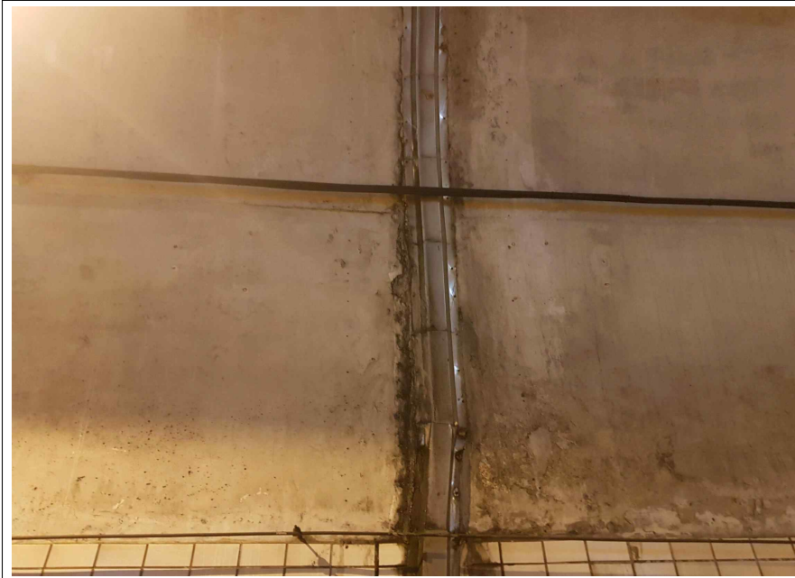
기존 누수방지판 설치 상태 (시공 전)(A-2)
